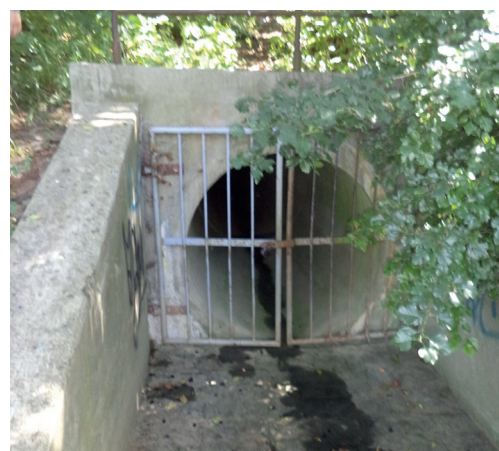
Výústní objekt odlehčovací stoky
