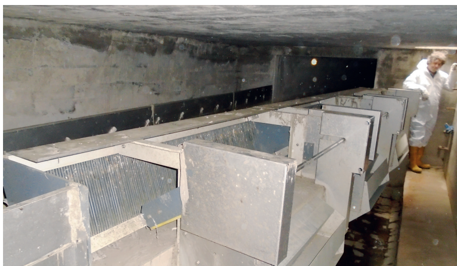
Výústní objekt odlehčovací stoky
