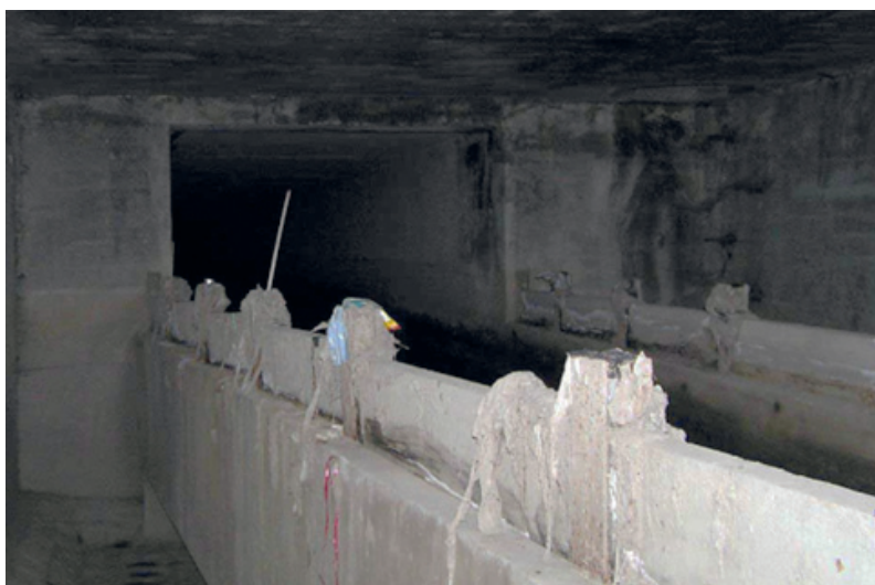
OK před rekonstrukcí
